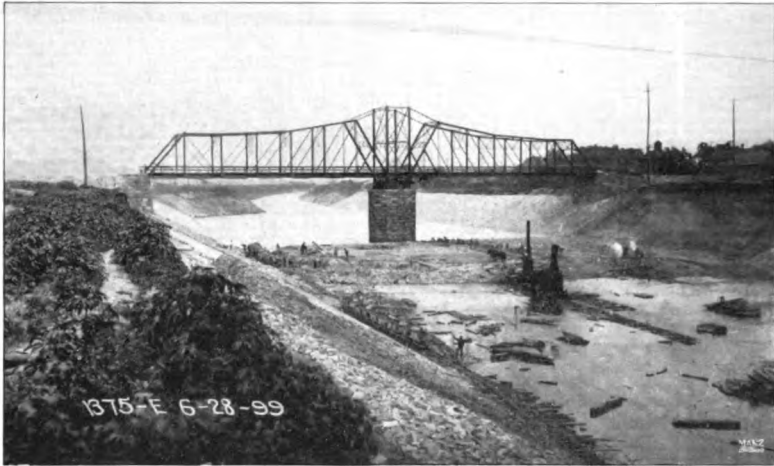
Fig. 9—Lyons-Summit Road Bridge.
