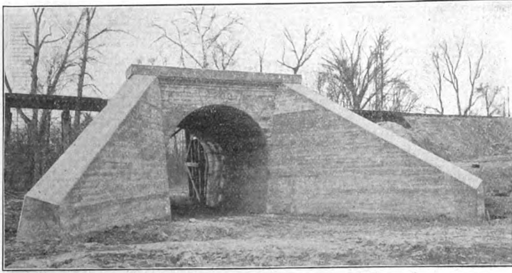
FIG. 12—16-FT. CONCRETE ARCH CULVERT.
